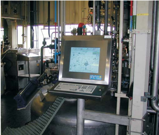
Bild 3: Gönzheimer PC100-Bildschirmarbeitsplatz mit kombinatorischem Explosionsschutz.
